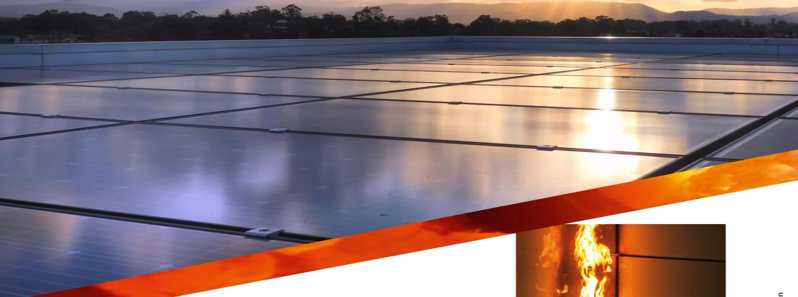
In PV-Anlagen können Brände auf unterschiedliche Weise auftreten. Eine gängige Ursache dafür sind elektrische Störungen im System, die einen Kurzschluss verursachen. Möglicherweise liegt dies an einer unzureichenden Installation, einer fehlerhaften Verkabelung oder einer unzureichenden Wartung.
